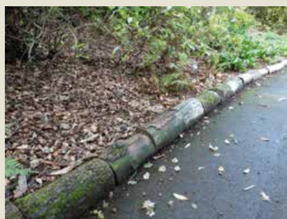
Utilización de troncos de podas como elemento estructural (Kew Garden, Londres).
